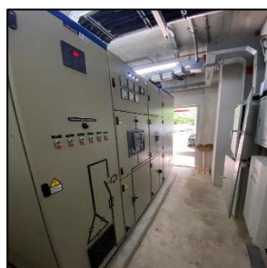
ภาพที่ 2.1-6 ระบบจ่ายไฟฟ้า
